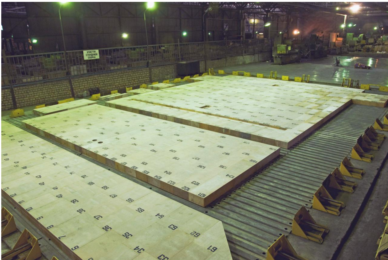
Рис. 5 – Стенд для сборки дна стекловаренной печи.
