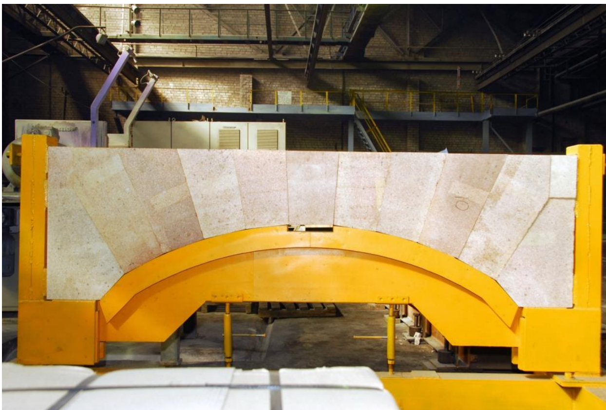
Рис. 4 – Стенд для сборки арочных конструкций с собранной поднасадочной аркой.
