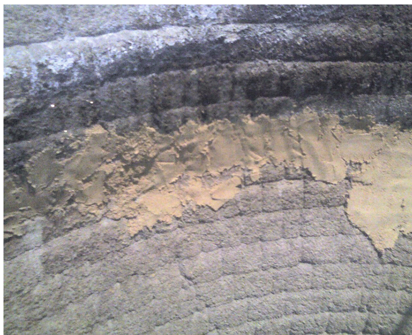
Рисунок 7 – Нанесенная на изношенные участки футеровки масса ПШРМ
