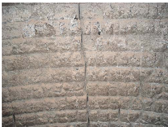
Рисунок 3 – Вертикальная трещина в шлаковом поясе
