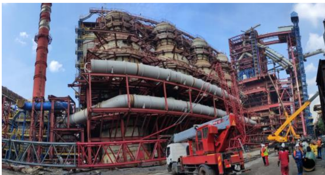
Рисунок 7 - Внешний вид строящихся воздухонагревателей ДП №3 ПАО «Северсталь».
